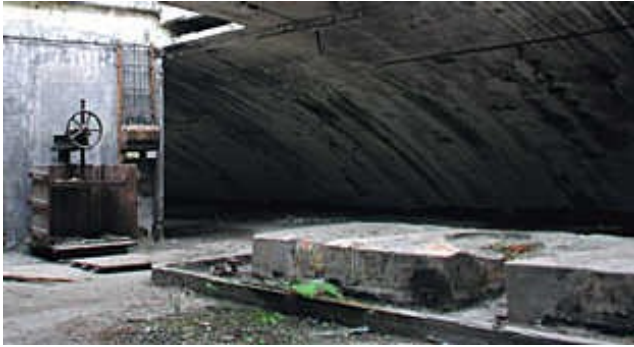
mischbunker-innen2: recht aufgeräumt und einige Überreste alter Anlagen
