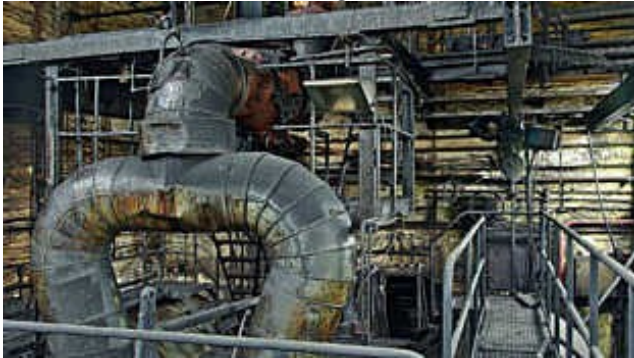
pulverm-innen2: riesengroße Metallrohre über irgendwelchen Anlagenresten
